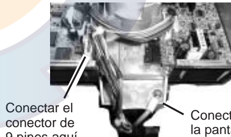
Conexión de la pantalla del cable de antena a tierra
